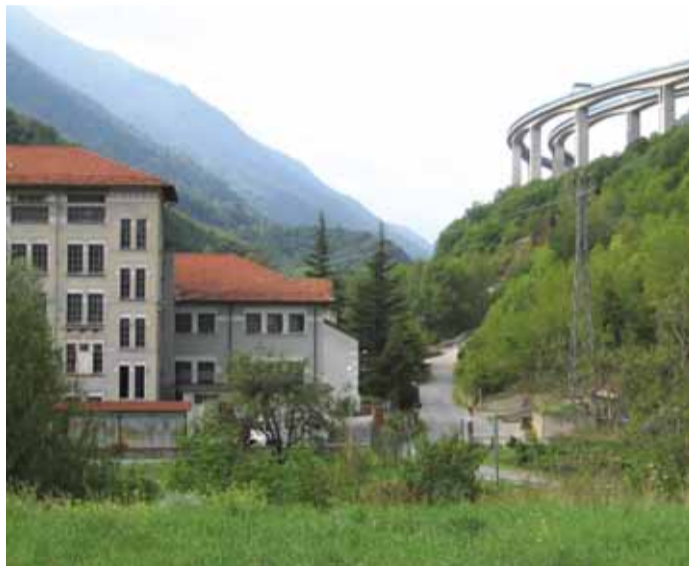
Chiomonte, Colombera: la centrale idroelettrica e il viadotto dell'autostrada del Frejus
