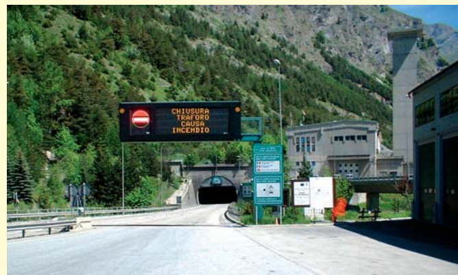
L'ingresso del Traforo del Frejus
